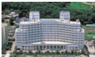
エクシブ淡路島 兵庫県洲本市小路谷字古茂江 1275-3
